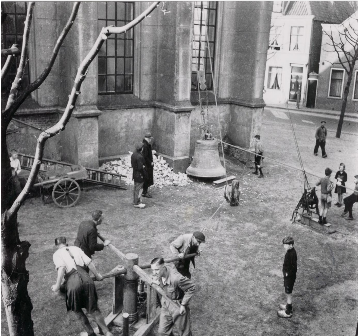
Figuur 3, Plaatsing kerkklok vlak na Wereldoorlog II in de Dorpskerk van Abcoude
