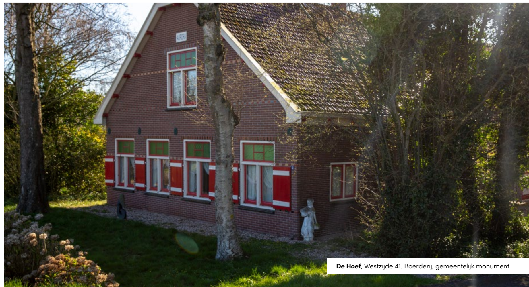
De Hoef , Oostzijde 24. Arbeiderswoning, beeldbepalend. Voorbeeld van bodemdaling.
