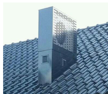
Warmtewisselaar ontworpen als schoorsteen
