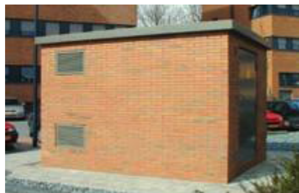
Trafo's in metselwerk uitvoeren
