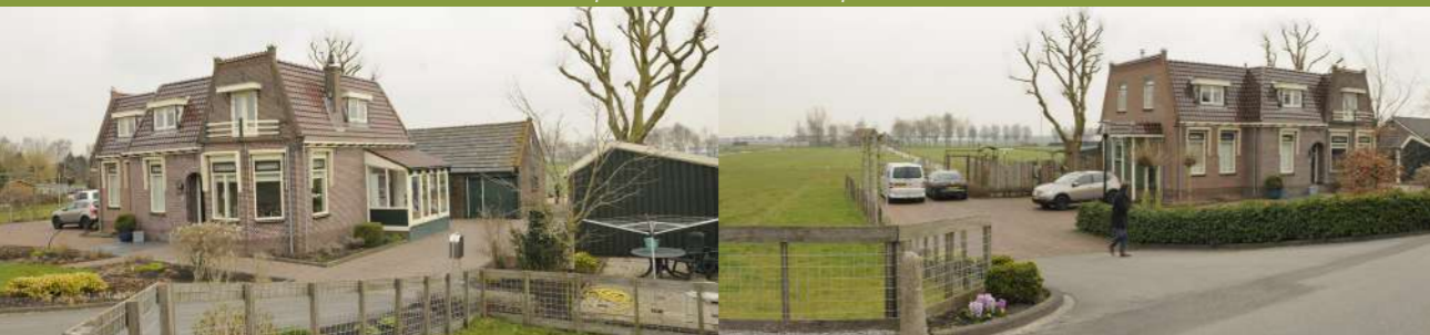
Door de oprit en de bijgebouwen te verwijderen, komt de woning weer aan het landschap te liggen.
